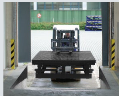
Montarea unei noi rampe de egalizare
