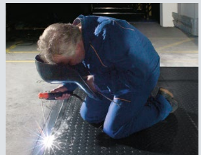
Soudage au niveau des cornières périphériques – Terminé.
