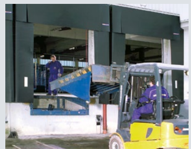
Démontage de l'ancien niveleur de quai, adaptation de la fosse le cas échéant (p. ex. avec des plaques de montage ou des consoles)
