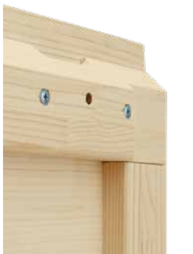
Verstärkung an den Lamellenenden
